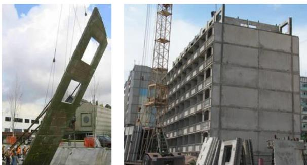
(d) Béton armé préfabriqué
